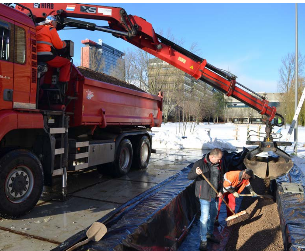
Ecologisch Waterbeheer gebruikt schelpen om hemelwater te bufferen en zuiveren.
